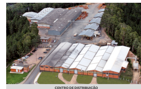
CENTRO DE DISTRIBUIÇÃO
